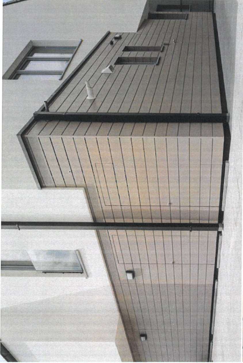
Połączenie deski Cedral z tynkiem
